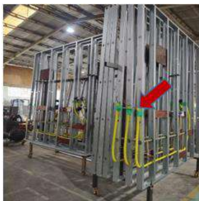
Perfis Soldados, com instalação da tubulação elétrica e hidráulica
